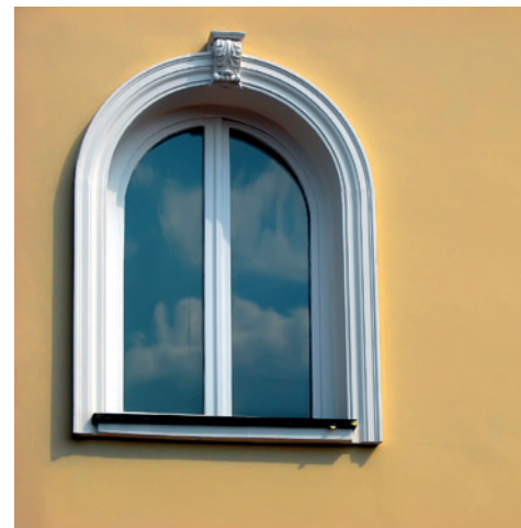
Fenêtre 2 vantaux plein cintre
