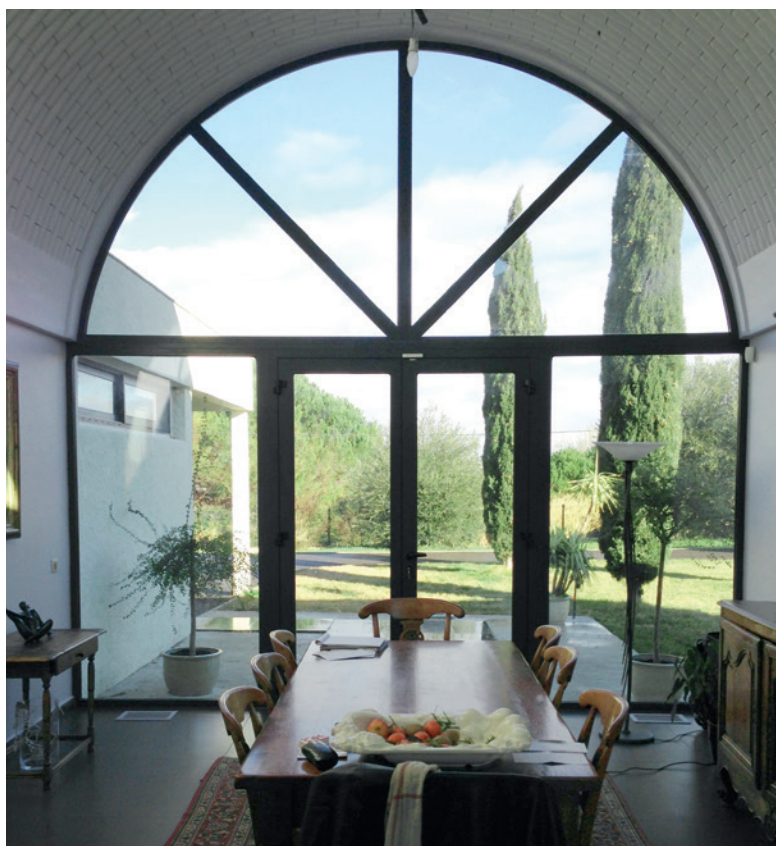
Porte d'entrée 2 vantaux avec 2 fixes latéraux Imposte cintrée avec 3 petits bois rayonnants
